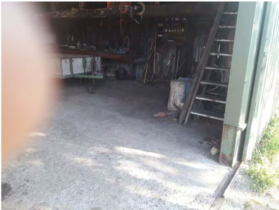
Carport en werkplaats
