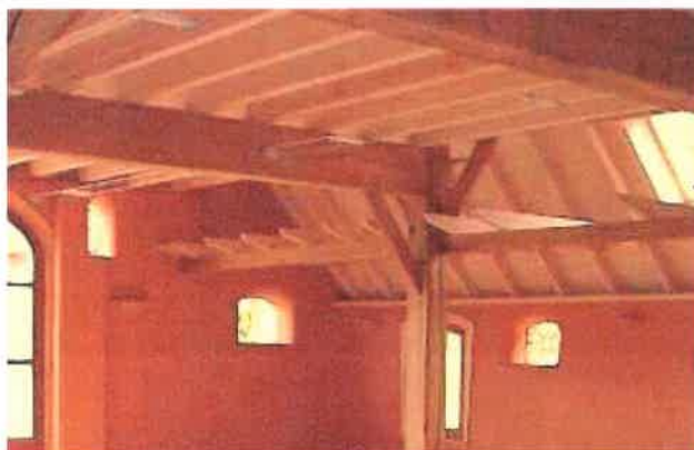
Aanbrengen binnenisolatie. Vergunning nodig.
