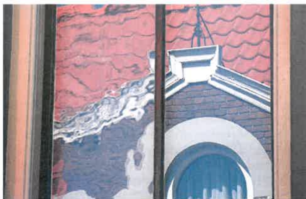
Vervanging van oorspronkelijk mondgeblazen glas (links) door modern glad floatglas (rechts), beide in een oud raam. Vergunning nodig.
