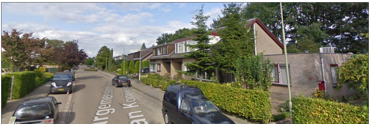
Straatbeeld Burg. H. van Konijnenburglaan, met rechts op de voorgrond de woning (nummer 2) en de aanbouw
